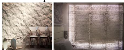
Рисунок 2 – Дневное/ночное освещение 3D-панелей из литьевого камня с добавлением фиброоптического волокна
